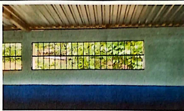
Foto 2: Las ventanas instaladas por completo para tener buena iluminación.
