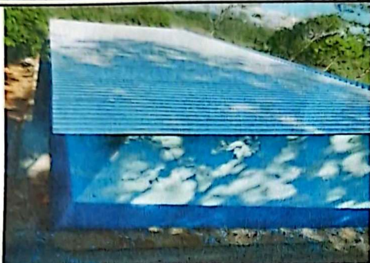
Foto1: Cambio del techado del establecimiento completado
