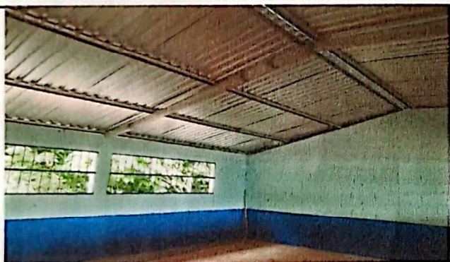
Foto 3: Instalacion de Vigas Costaneras de metal completado
