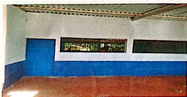
Foto 5: Instalacalon de puertas de metal completado
